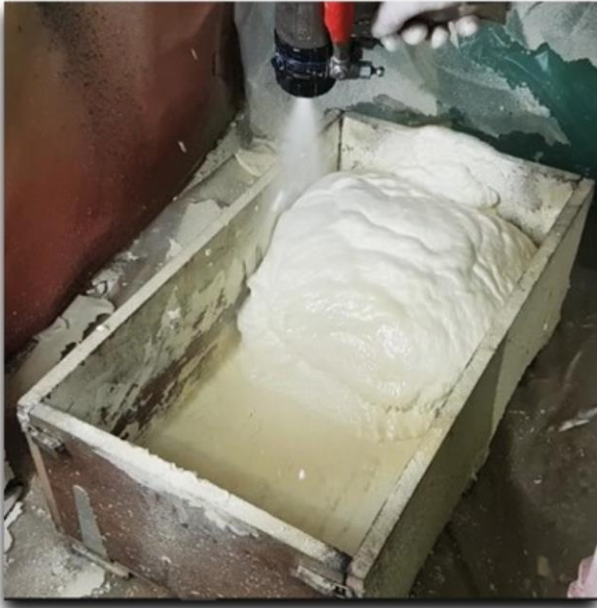
Projeter le liquide sur le support, la mousse doit être expansé de manière à complètement remplir le cadre
